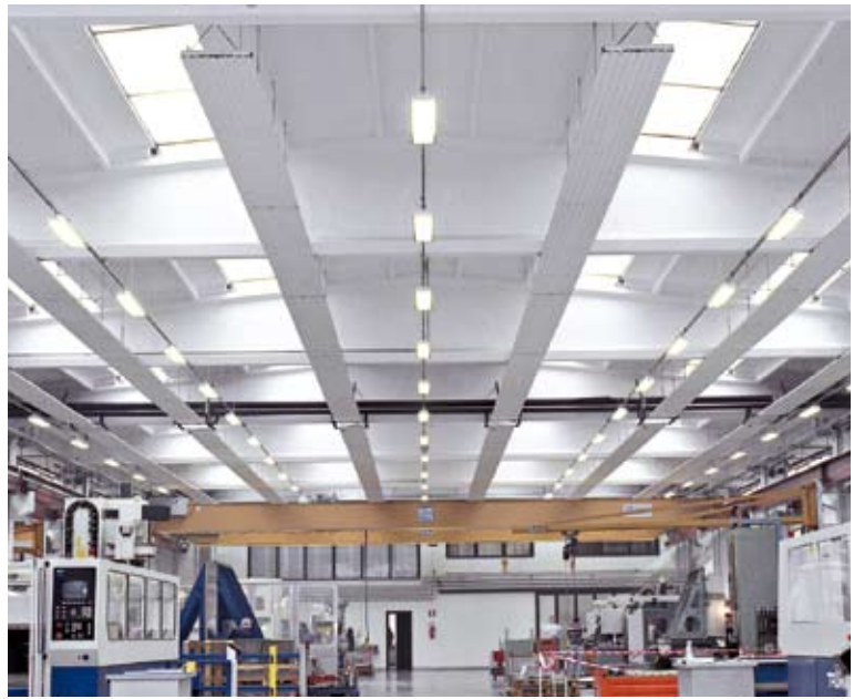
Панели SZ – это комфортный, равномерный прогрев требуемых пространств. Они не занимают полезной площади помещения.
