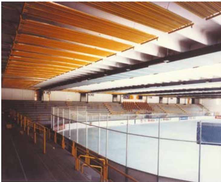
Оптимальное решение для спортивных сооружений. Приборы греют зрителей на трибунах, а ледовое поле находится вне зоны их действия.
