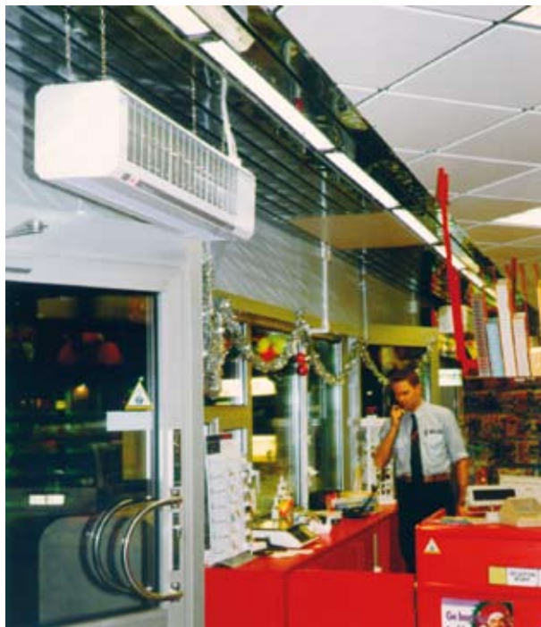
Крепление к потолку на стержнях
