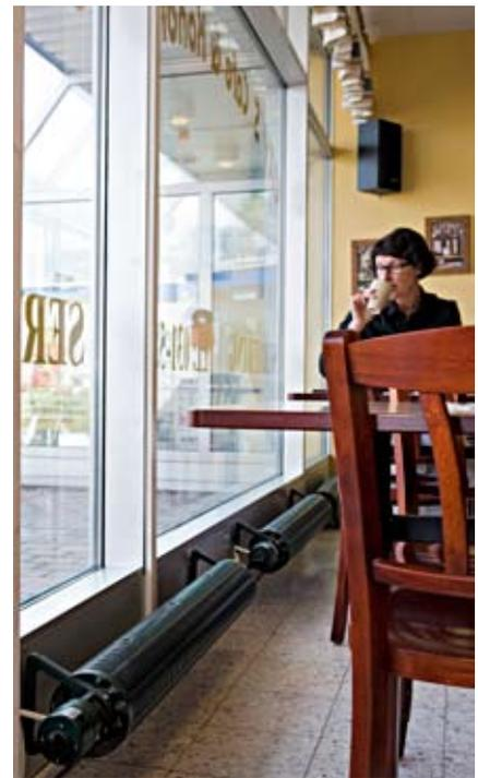
Конструкция приборов удобна и проста в монтаже. Их можно устанавливать даже под окнами.
